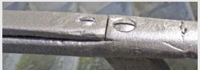
Rechts Originalschraube, links Ergänzung zum Wiederbefestigen des Handlaufes
