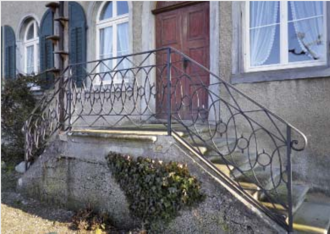
Die Zierbemalung des Geländers und die Restauration der Treppe werden vom Bauherrn noch ausgeführt
