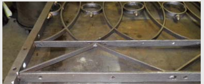
Dutzende von ungenutzten Löchern, die teils mit Blei ausgerieben waren, kamen zum Vorschein
