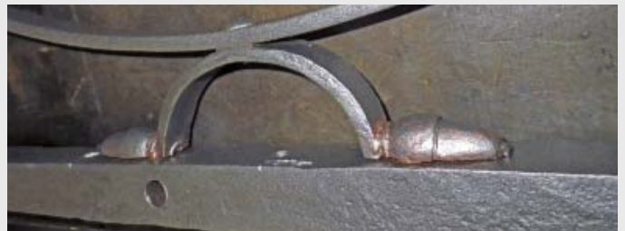
Die Füllungsbögen sind mit Dornen in die Pfosten gesichert
